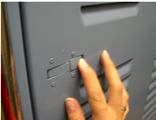
Foto 6: Abrir la puerta trasera del rack de la electrónica.
