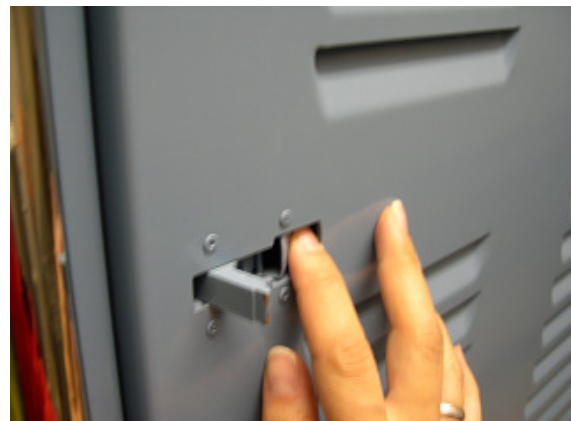
Foto 7: Para abrir la puerta, apoyar el pestillo de la derecha para soltar el de la izquierda.
