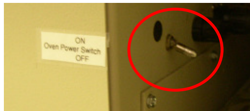
Foto 14: Interruptor del horno.
