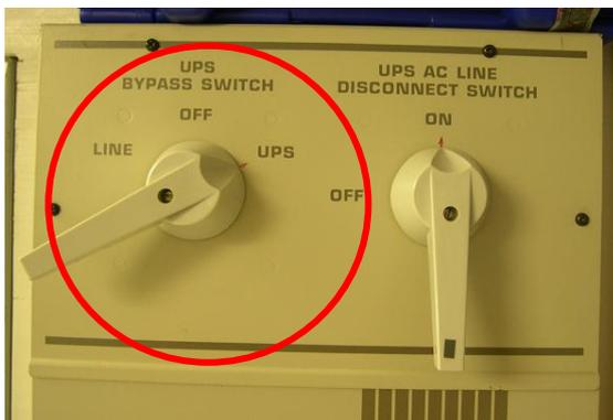
2. Colocar la palanca UPS AC LINE DISCONNECT en la posición OFF. Esto corta el suministro desde el exterior a la UPS.
